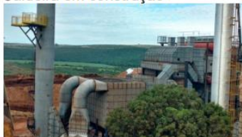
Caldeira em construção
