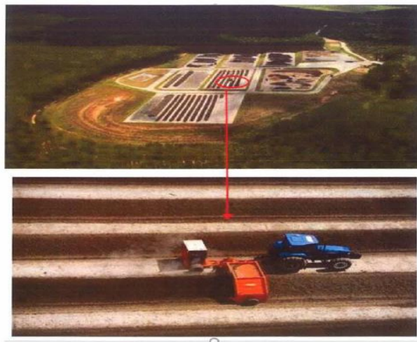
Figura 71: Central de compostagem da unidade de Limeira (terceirizada).
