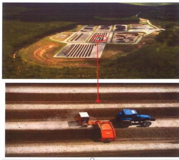
Figura 71: Central de compostagem da unidade de Limeira (terceirizada).
