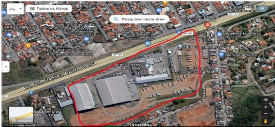
Fotos extraídas do aplicativo Google Maps da sede das empresas fiscalizadas quando das suas constituições – Centro Logístico na Rodovia SP 101, KM 14,5
