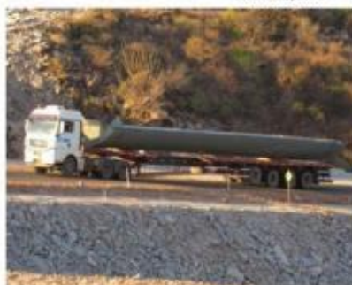
Figura 49 – Transporte da aduela para o local de montagem.
