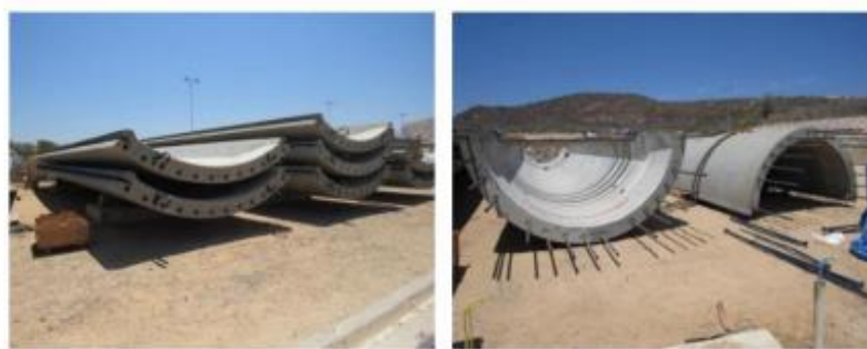
Figuras 47 e 48 – Aduelas em estoque aguardando transporte para o local de montagem.
