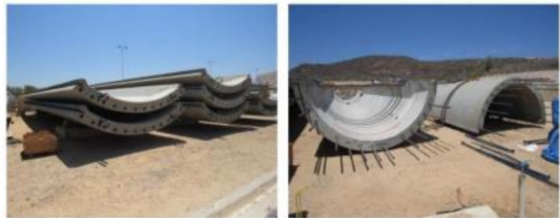
Figuras 47 e 48 – Aduelas em estoque aguardando transporte para o local de montagem.
