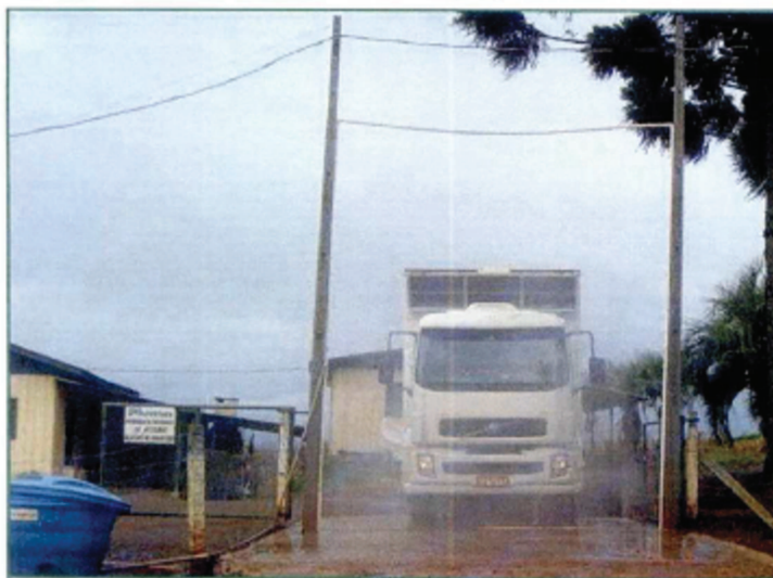
Sistema de arco de desinfecção aos veículos
