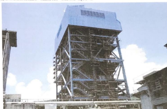
Montagem Tubulações Isolamento Refratário - Caldeira CBC - Obra Osa - Itapeva - SP
