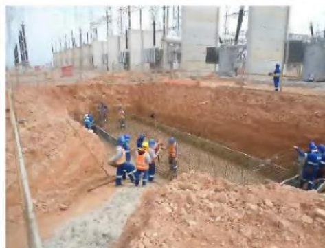
Figura 148 – Serviços de construção civil na subestação.
