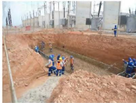
Figura 148 – Serviços de construção civil na subestação.
