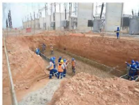
Figura 148 – Serviços de construção civil na subestação.
