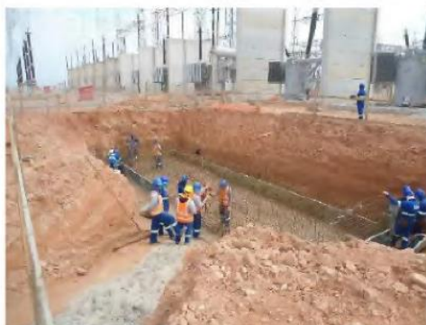
Figura 148 – Serviços de construção civil na subestação.
