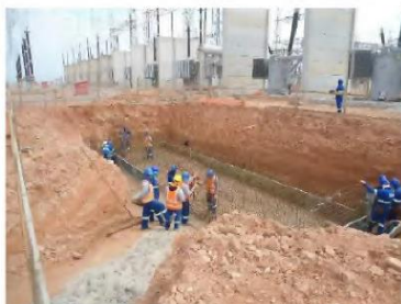
Figura 148 – Serviços de construção civil na subestação.
