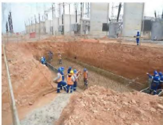
Figura 148 – Serviços de construção civil na subestação.
